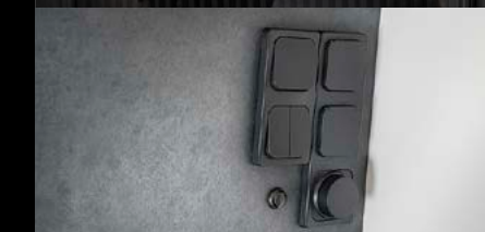
9 Des prises électriques là où vous en avez besoin
